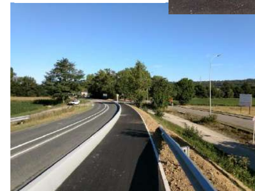
CVCB Réalisée à Saint-Maurice-de-Beynost - CCMP
