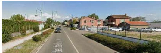
Deux larges voies de circulation. Des trottoirs paysagers et larges. Des revêtements pour l'espace public peu qualitatif sur un espace partagé entre vélo et piéton.
